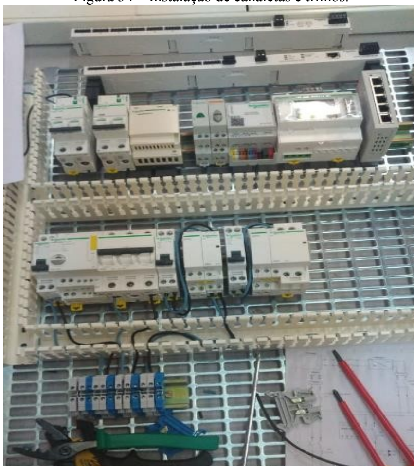
Figura 34 – Instalação de canaletas e trilhos.
