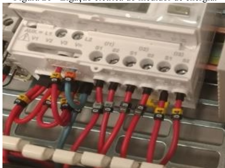
Figura 26 - Ligação elétrica do medidor de energia.
