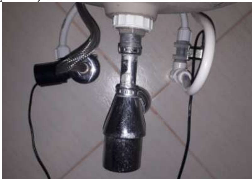
Figura 79 – Implementação do sistema de bombeamento.
