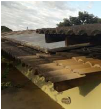
Figura 29 – Placas Coletoras Residência 2.
