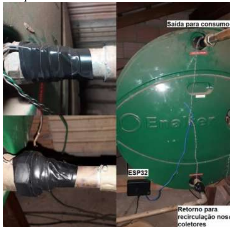
Figura 78 – Implementação dos sensores no boiler.
