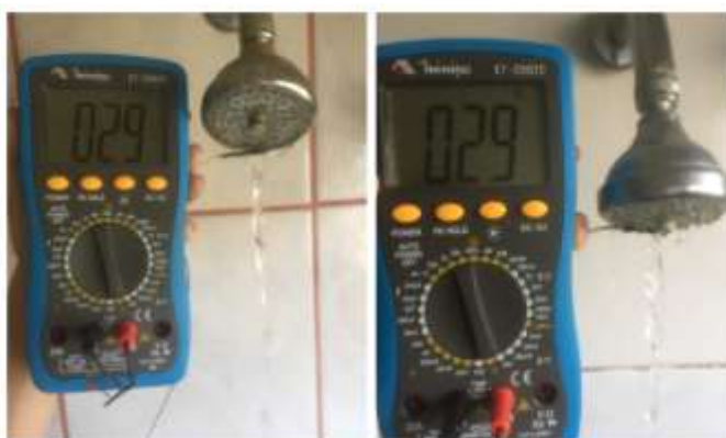
Figura 38 – Temperatura inicial no dois banheiros da Residência 1.
