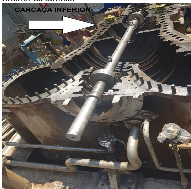
Figura 20 – Carcaça inferior da turbina.
