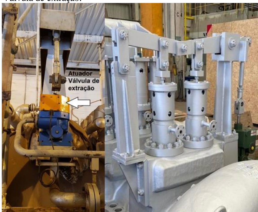
Figura 27 – Válvula de extração.
