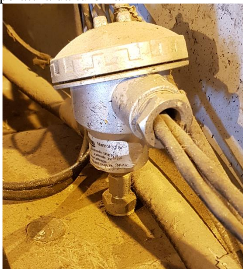
Figura 30 – Sensor de temperatura da turbina.
