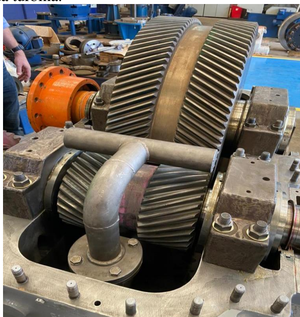
Figura 29 – Redutor da turbina.
