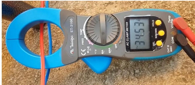
FIGURA 34 - Corrente do sistema em funcionamento.
