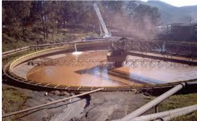
FIGURA 5 - Tanque espessador de minério.
