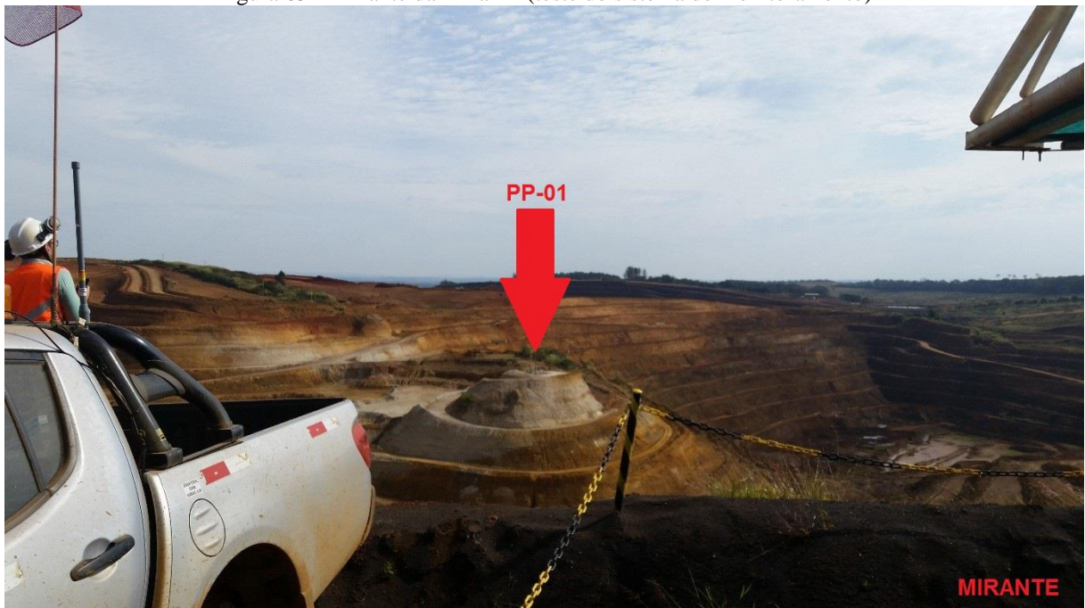
Figura 65 – Mirante da mina F4 (teste do sistema de monitoramento)
