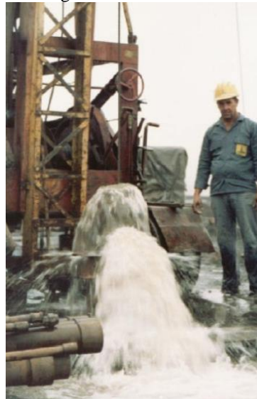
Figura 3 – Bombeamento de água subterrânea através de poço tubular profundo
