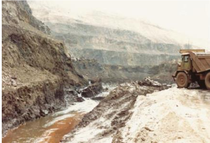
Figura 2 – Abertura de trincheiras para drenagem e condução de água aos sumps
