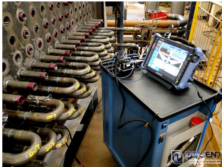
Figura 27 - Inspeção por ultrassom em serpentina de superaquecedor de vapor
