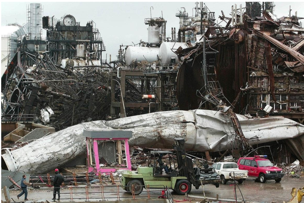
Figura 25 - Explosão de caldeira em Skikida, Argélia - 2004
