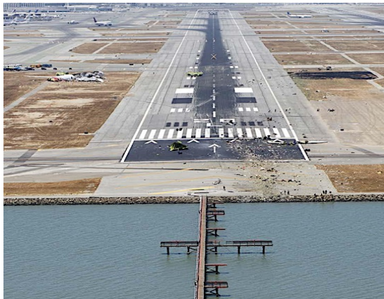
Figura 18 - Parede quebra-mar onde ocorreu o primeiro impacto. Fonte: JACDEC (2014).
