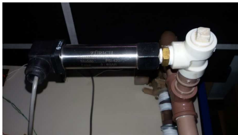
Figura 35: Transmissor de Pressão utilizado no projeto
