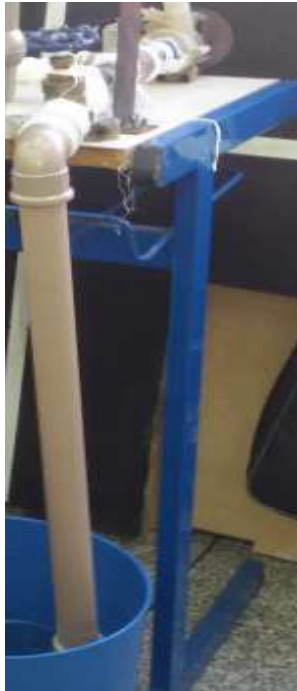
Figura 26: Tubulação de Sucção
