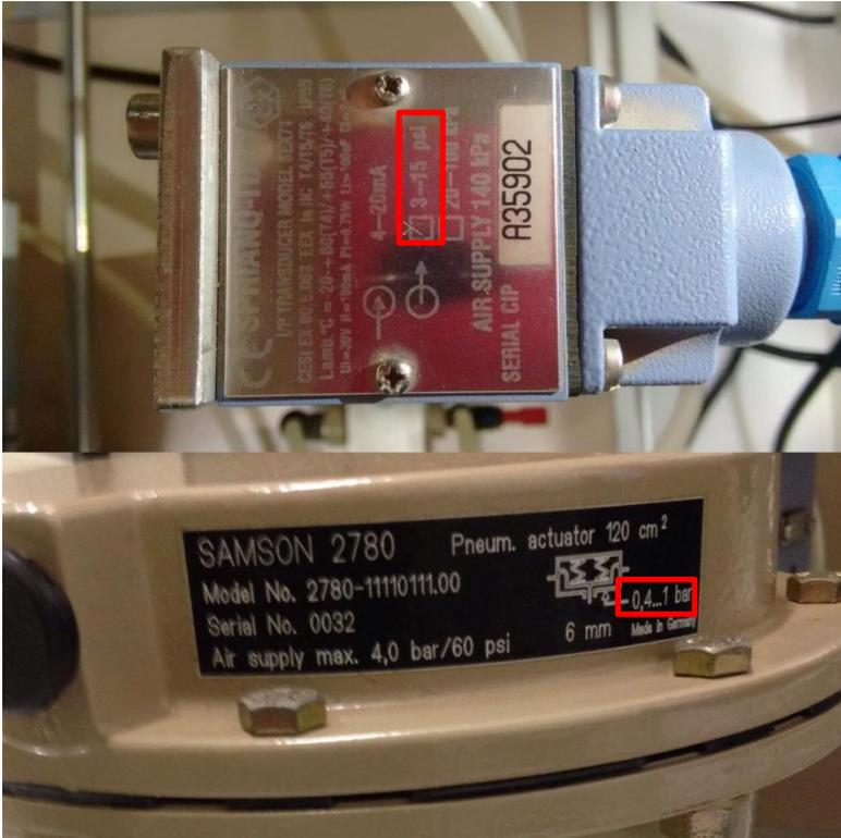
Figura 12: Placa descritiva do atuador e da válvula de controle
