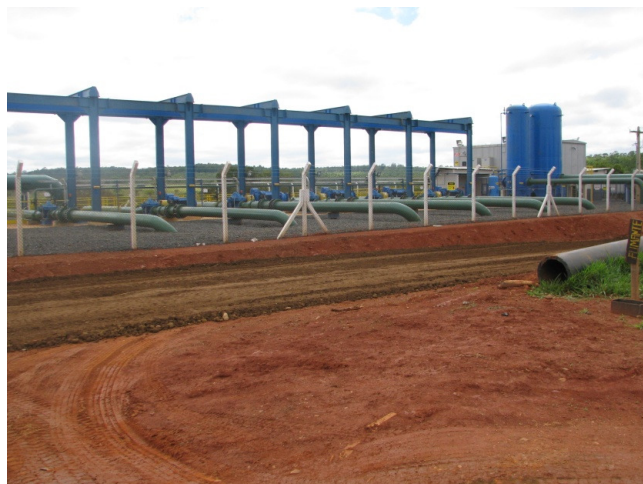
Figura 3-3 - Sistema fixo de bombeamento
