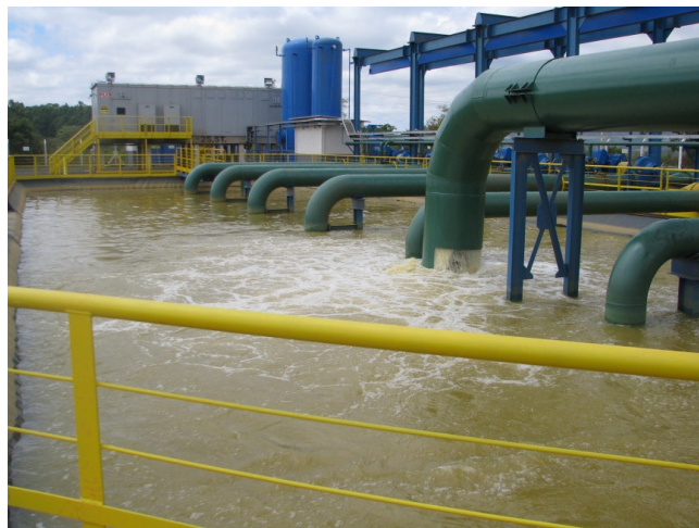
Figura 3-3 - Sistema fixo de bombeamento
