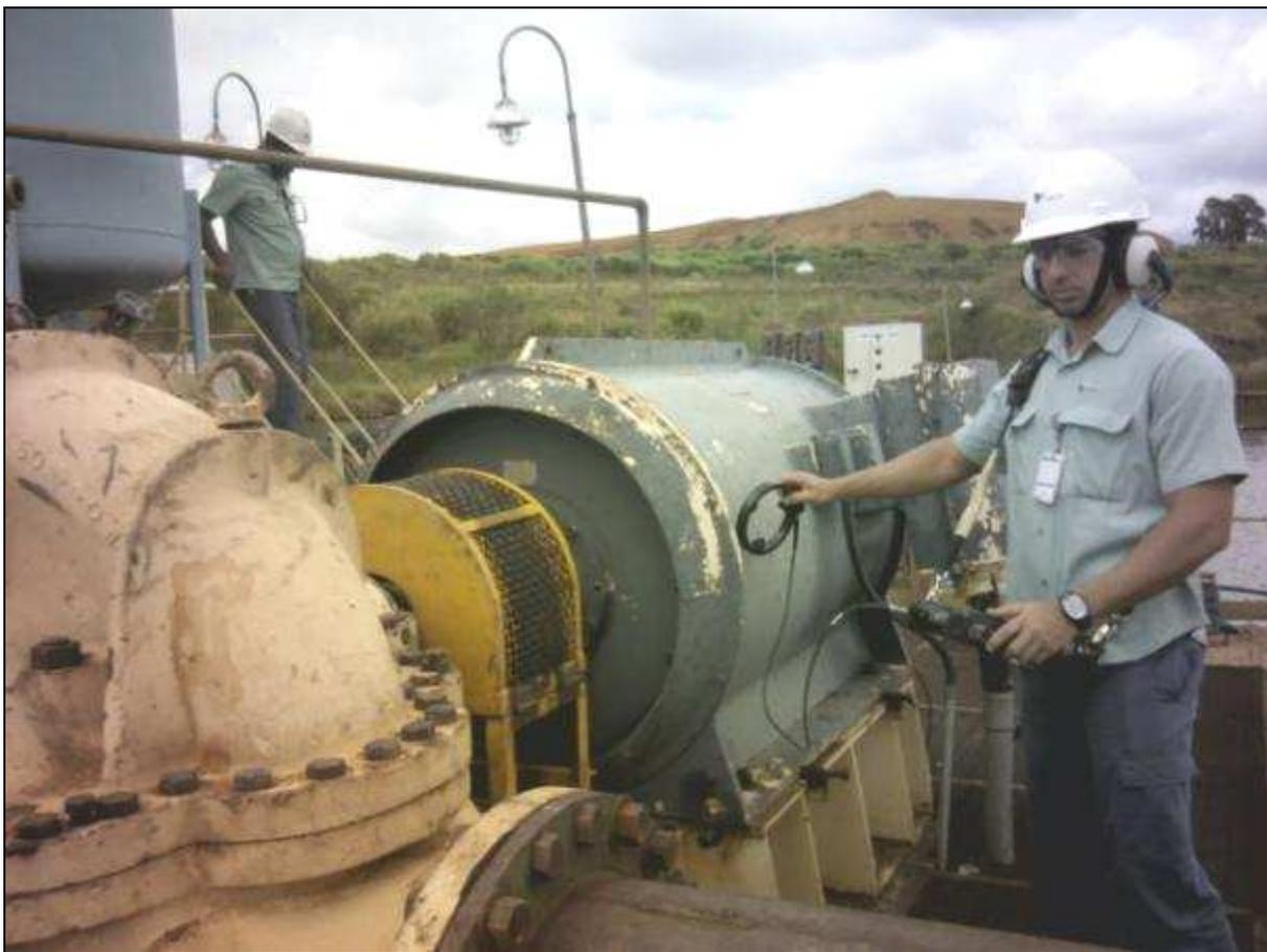
Figura 62 - Motor da bomba 62.21.01 - Medição de Fluxo magnético
