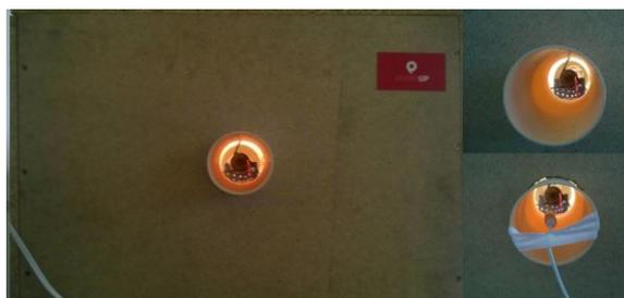
Figura 73 - Saída de ar e detalhe do sensor de temp. e umidade.
