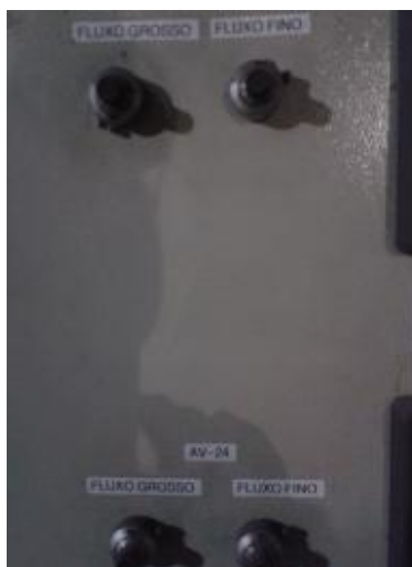
Figura 36 - Potenciômetros para ajuste manual das calhas vibratórias
