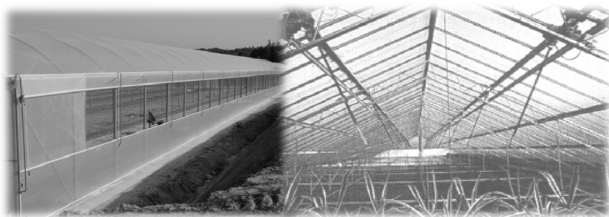
FIGURA 6 - Ventilação por aberturas laterais e na parte superior de estufas Fontes: http://www.fertri.com/portuguese/productos/multitunelcaracteristicas . METRÓLHO, 1999, p. 13.
