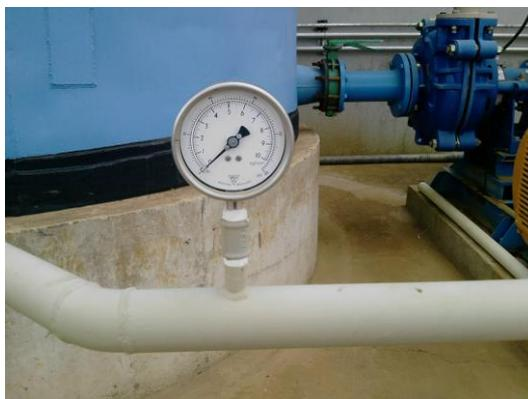
Figura 5 - Manômetro Tubo de Bourdon
