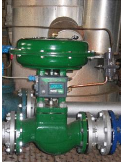
Figura 18: Exemplo de saída analógica, válvula proporcional
